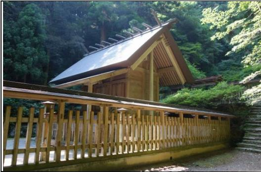
写真⑧ 本殿。銅板葺、千木(水平)、鯉木(8本)、棟持柱を持ち、高床形式で高欄は無い。神明造形式。
